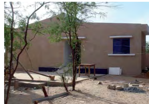
Maternité de Kael, en fin de construction.
